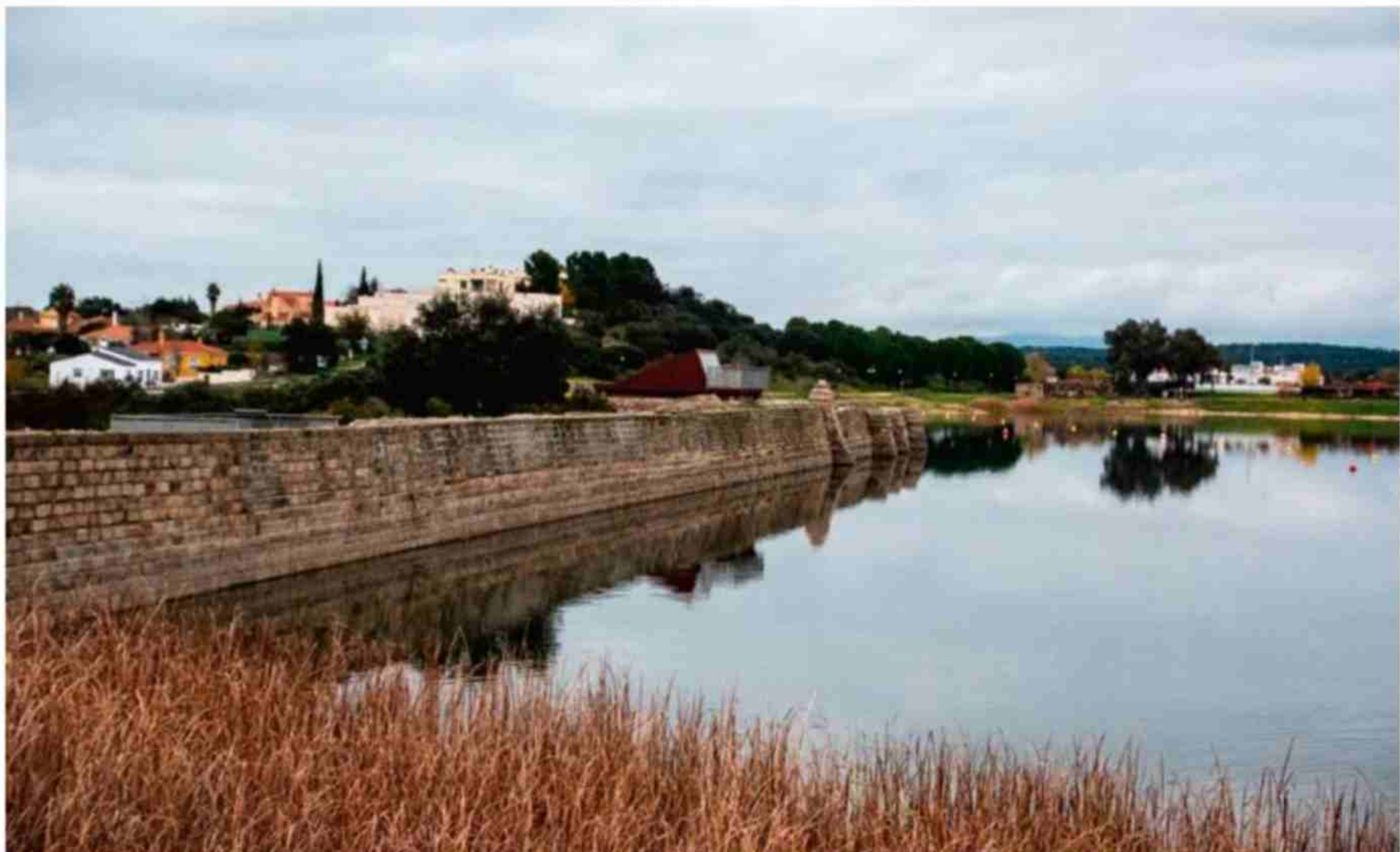
Presa de Proserpina, situada a 5 km al norte de Mérida.
