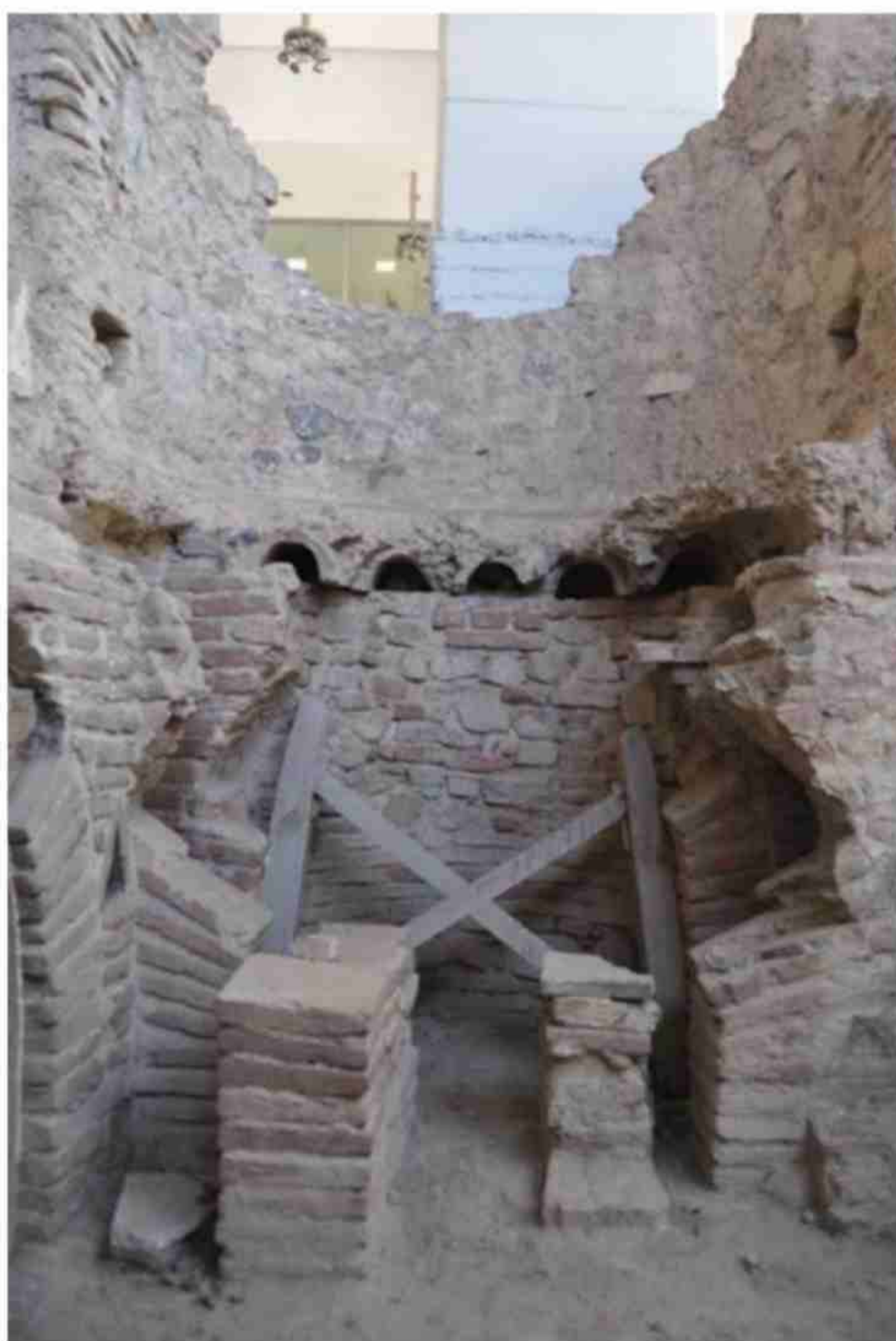
Hypocaustum con arcadas de ladrillos de los baños de la Casa de los mármoles de Morería. La suspensura se apoya en tejas curvas que facilitan el paso de calor al suelo.
