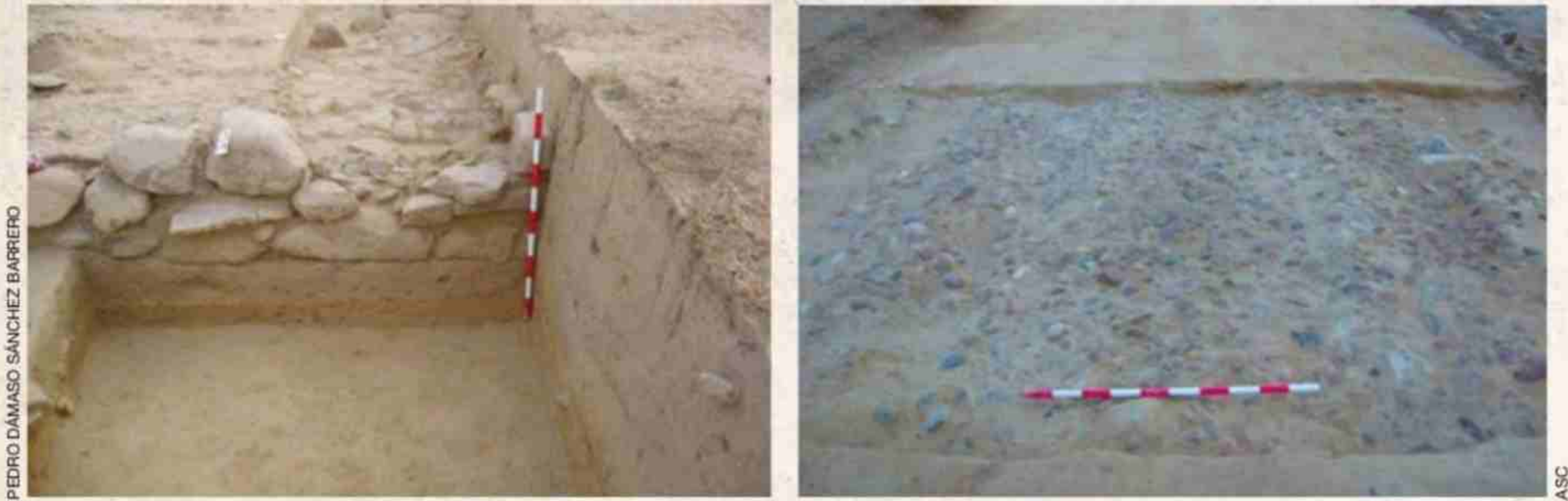
De izda. a dcha., detalle de una vía romana en el entorno de Mérida donde es visible la rodadura y la primera capa o base de la calzada; detalle del encintado de la vía romana al norte de la ciudad.
