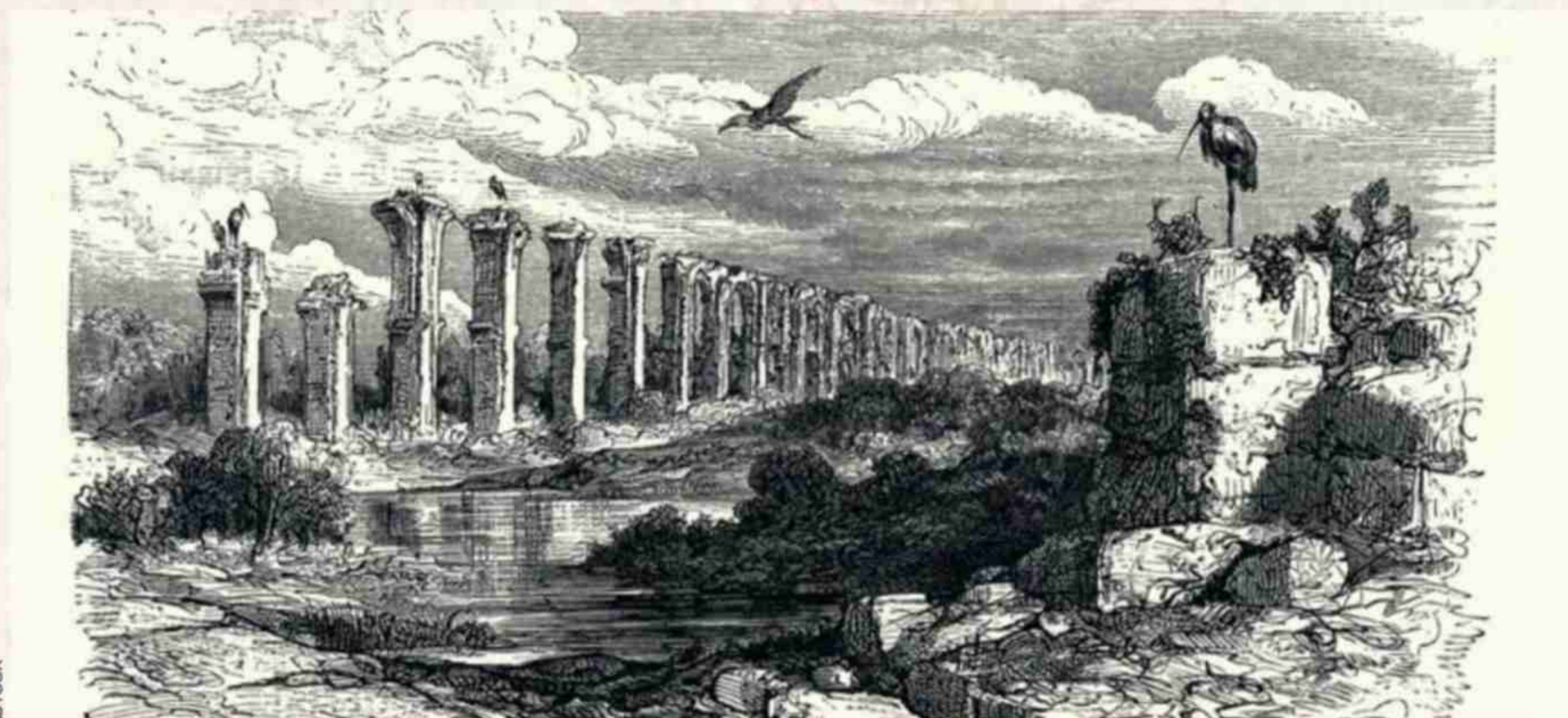
El acueducto romano conocido como «de Los Milagros» que abastecía de agua a la ciudad y cuyo origen tradicionalmente se ha situado en el pantano de Proserpina o Charca de la Albuera.
